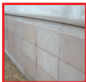
原墙： 粘土砖墙 干挂红砂岩
