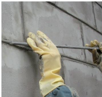
原墙： 粘土砖， 外贴砂岩
