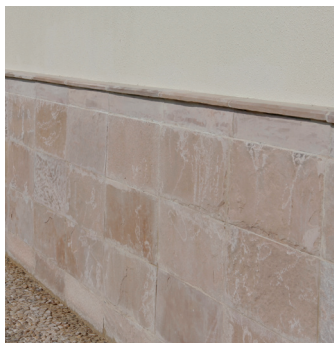
原墙： 粘土砖墙 干挂红砂岩
