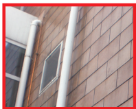
原墙： 粘土砖， 外贴砂岩
